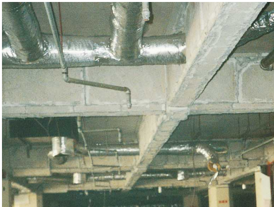
鉄骨耐火被覆
