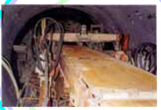
現場(シールド工事)
