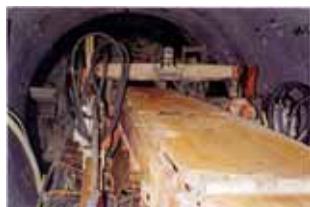
現場(シールド工事)
