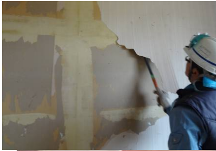
クロス類の撤去状況
