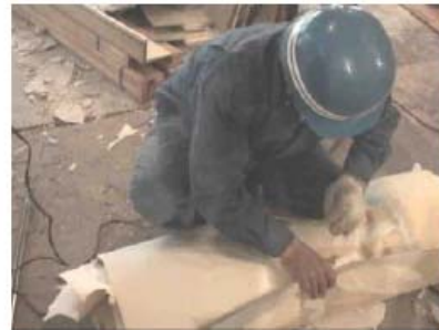
クロス類の結束状況
