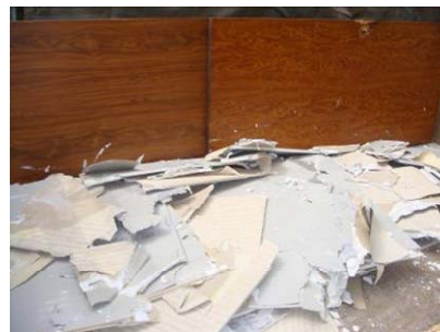
解体後の廃石膏ボードの保管
