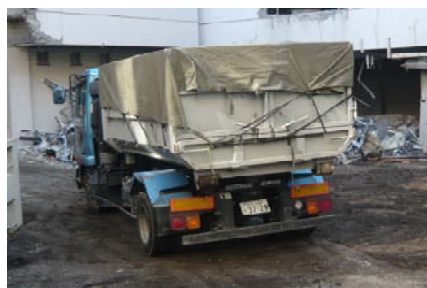
廃石膏ボードの運搬
