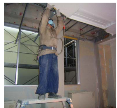
天井の撤去状況
