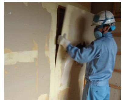
壁面の撤去状況
