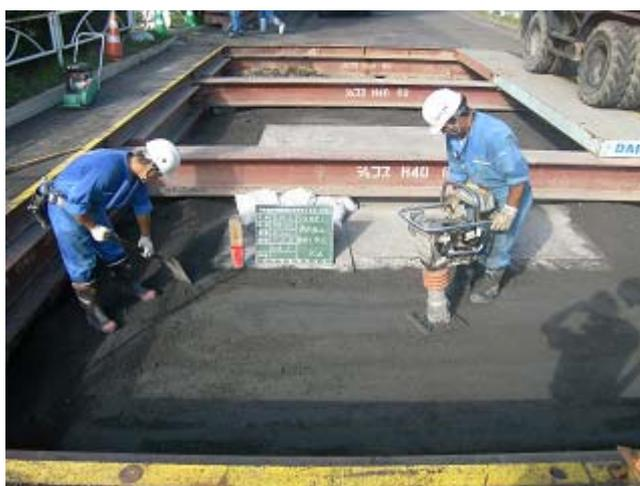
写真. 建設汚泥処理土埋戻し状況
