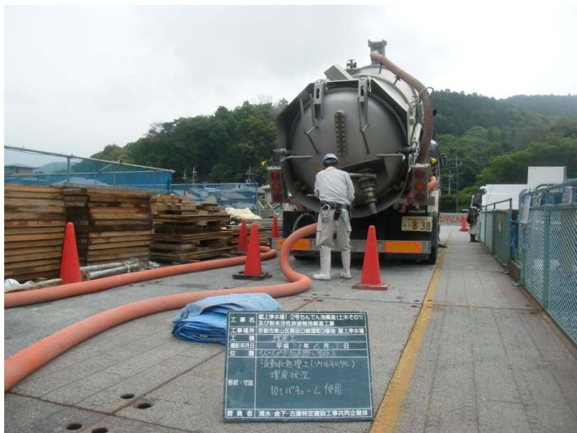
写真. 流動化処理土搬入
