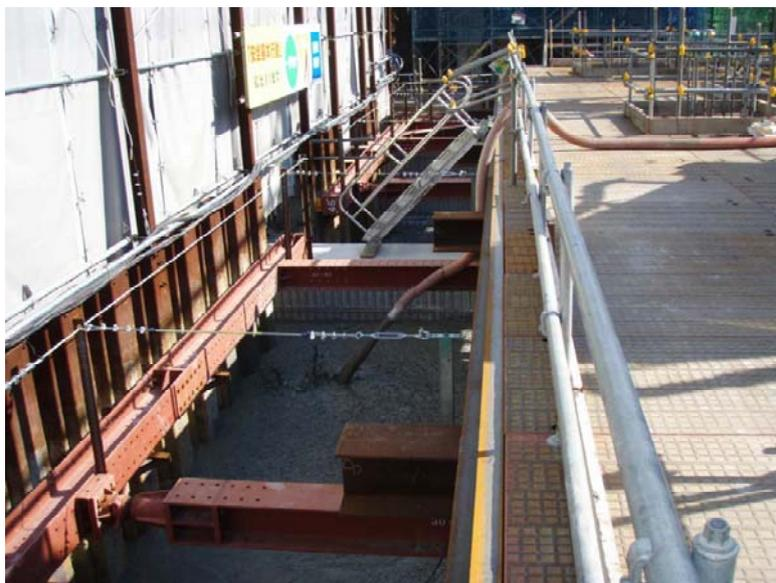
写真. 流動化処理土搬入状況
