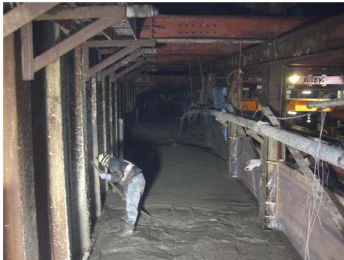
写真. 流動化処理土打設状況
