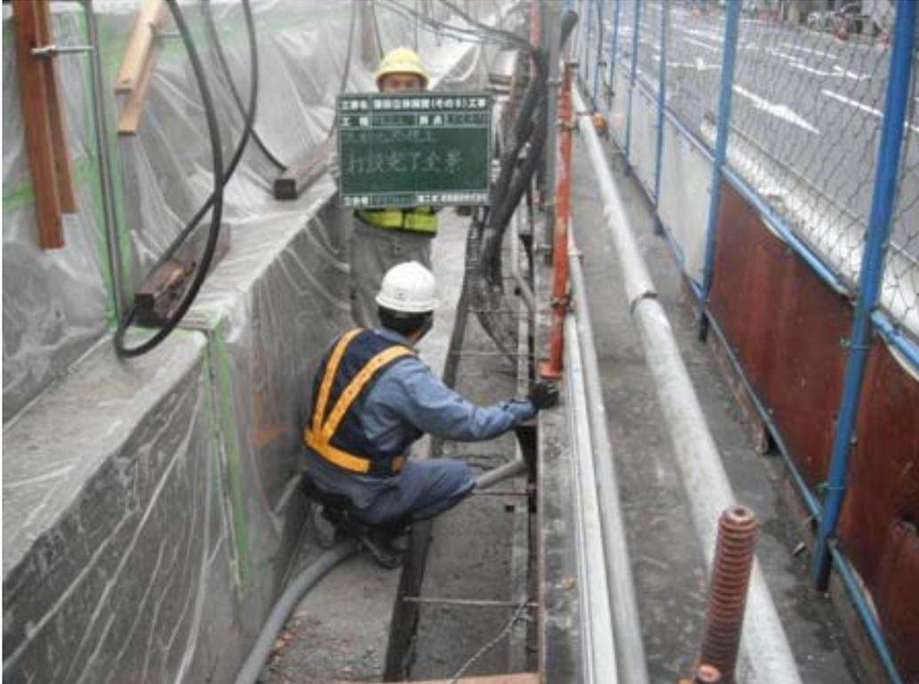
写真. 流動化処理土打設完了
