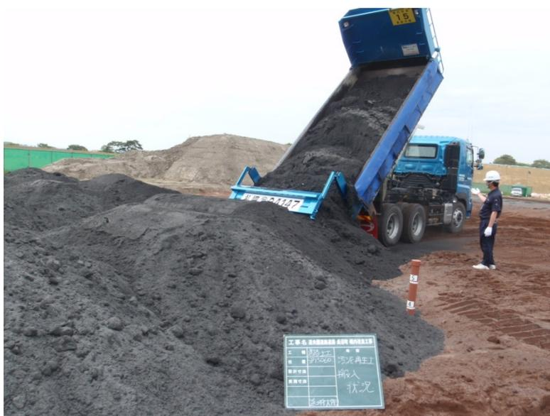
写真. 建設汚泥処理土搬入状況
