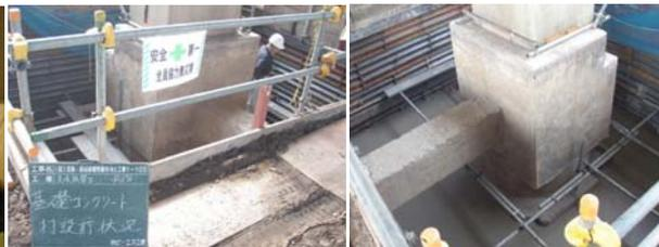
写真. 基礎コン打設状況
