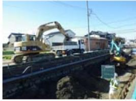
③改良土をバックホウにより掘削し、仮置き場へ搬出
