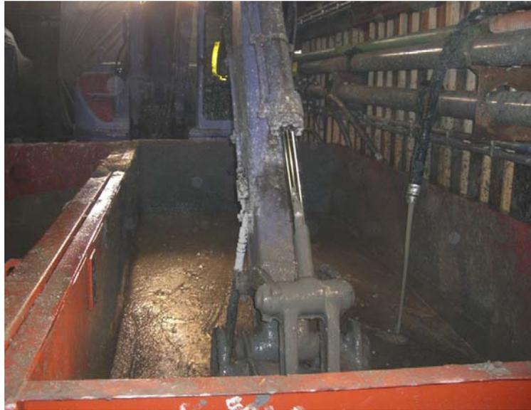
写真. 流動化処理土製造状況
