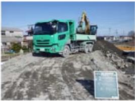
④U型水路設置後、仮置き場より改良土を埋戻し土として搬入
