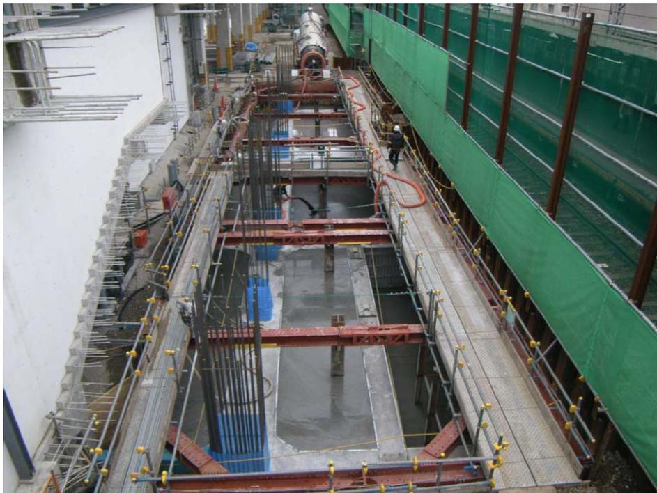
写真. 流動化処理土埋戻し状況
