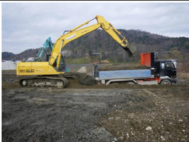
写真. 改質材積み込み状況
