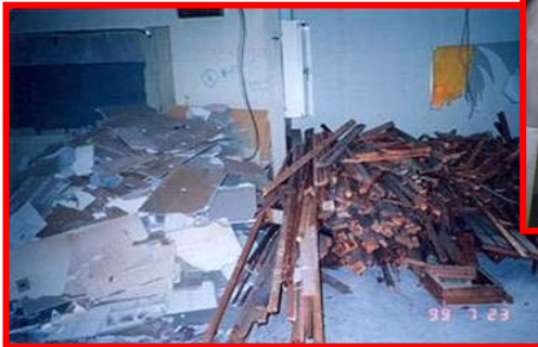
内装材(木材・廃石膏ボード)の分別
