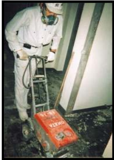
アスベスト含有形成版撤去
