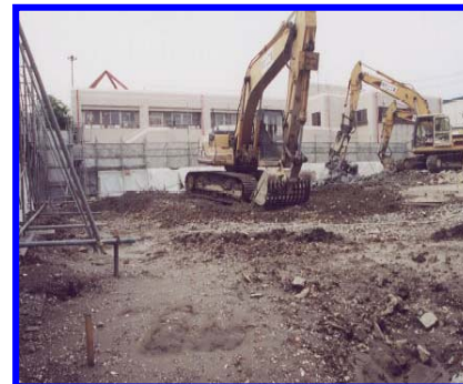
基礎及び基礎杭の取り壊し
