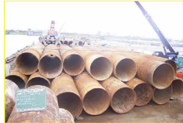
撤去された棧橋の鋼材
