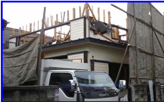
上家の解体(外装材、梁、柱等の取り壊し)
