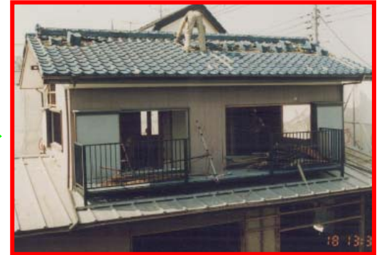
屋根葺き材の取り外し (防水シート等も取り外す)
