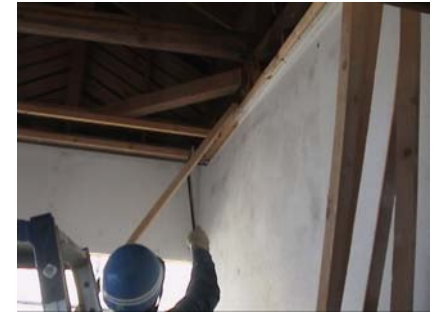
幅木除去の状況
