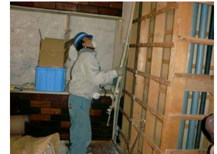
分別解体状況
