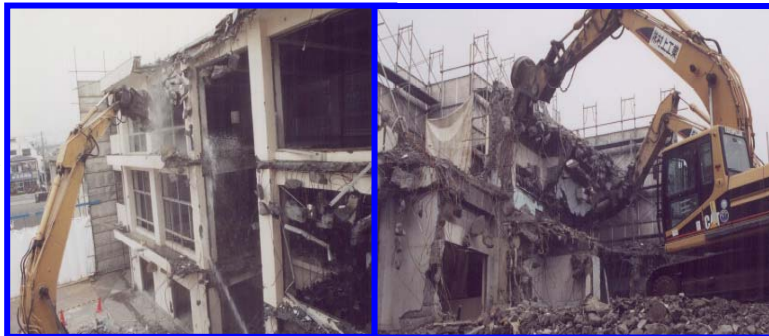
躯体の解体 (屋根、外壁、構造体を同時に取り壊し)
