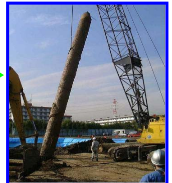
基礎及び基礎杭の撤去
