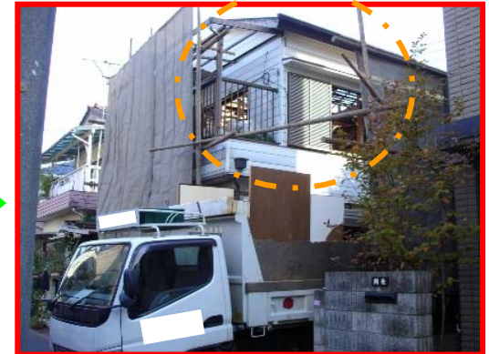
屋根葺き材の取り外し後 (防水シート等も取り外す)
