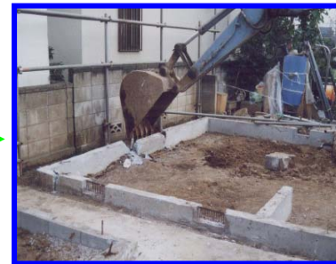
基礎の取り壊し (基礎杭がある場合も取り壊し)
