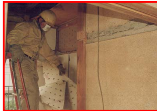
内装材(写真は石綿非含有建材)の取り外し (建築設備等も取り外す)
