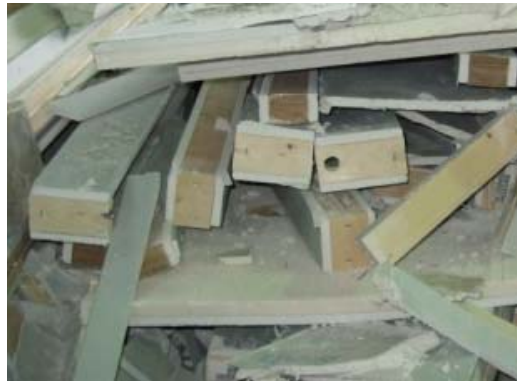
木くずと石膏ボードの複合材
