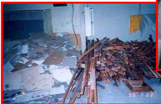
内装材(木材・廃石膏ボード)の分別
