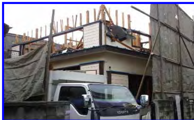
上家の解体(外装材、梁、柱等の取り壊し) 重機スペースが無い場合、手作業による分別解体
