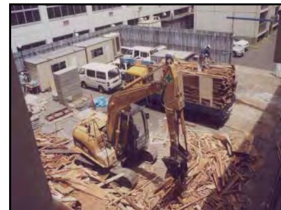
建設発生木材の分別・収集
