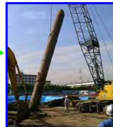
基礎及び基礎杭の撤去 20
