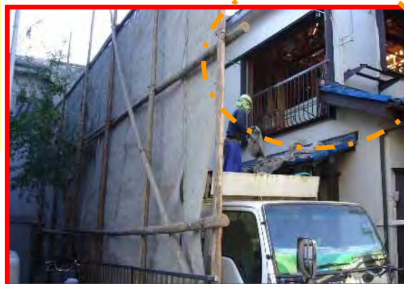
内装材の取り外し後 (建築設備等も取り外す)
