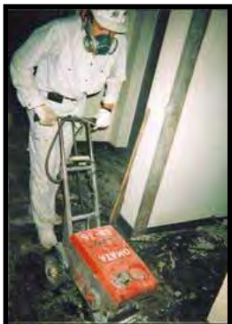
アスベスト含有形成版撤去
