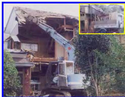
上家の解体(外壁、梁、柱等の取り壊し) (石綿含有建材の場合は手作業)
