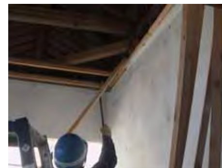
幅木除去の状況
