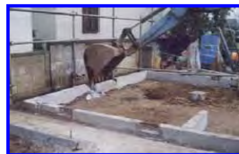
基礎の取り壊し (基礎杭がある場合も取り壊し)
