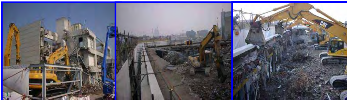
躯体の解体(屋根、外装材、構造体を同時に取り壊し)
