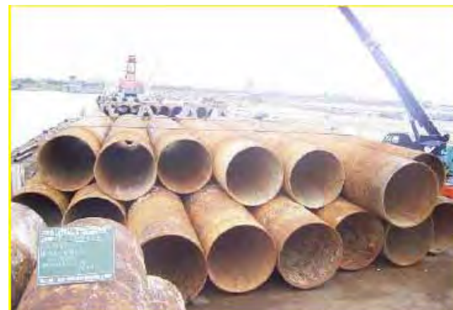
撤去された栈橋の鋼材
