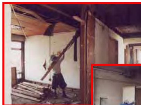
内装材の取り外し 写真は石綿非含有建材
