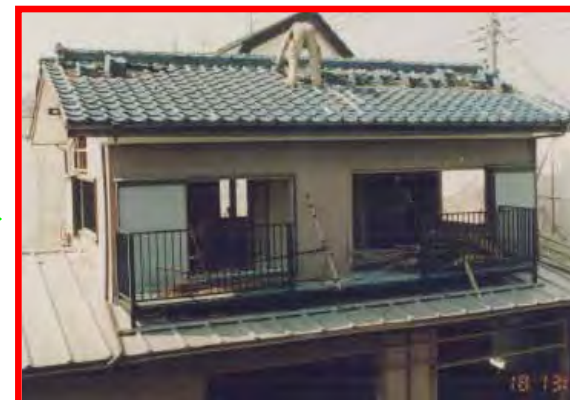
屋根葺き材の取り外し (防水シート等も取り外す)
