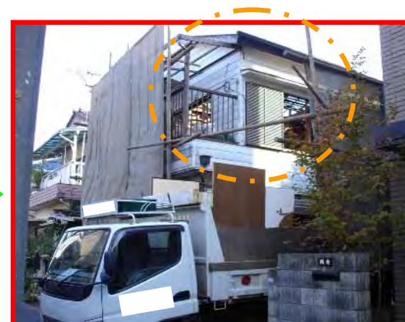
屋根葺き材の取り外し後 (防水シート等も取り外す)
