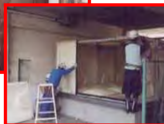
建築設備の取り外し
