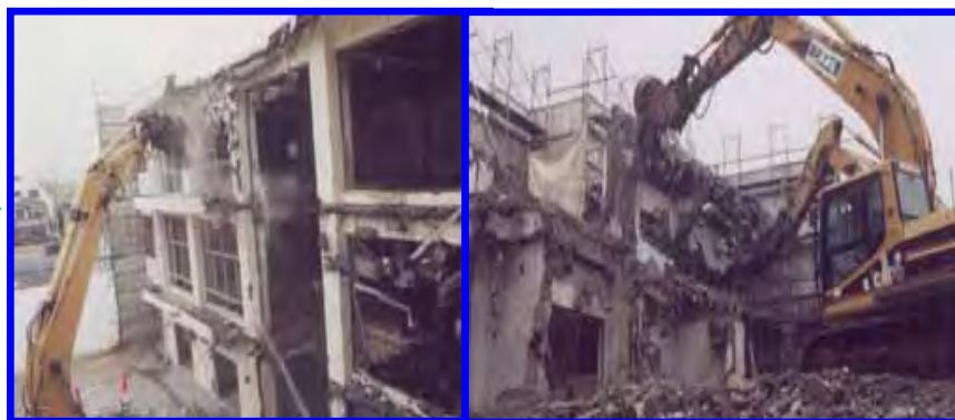
躯体の解体 (屋根、外壁、構造体を同時に取り壊し)
