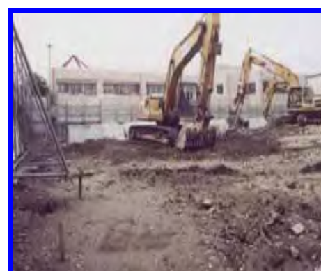
基礎及び基礎杭の取り壊し
