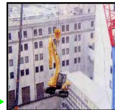
クレーンで重機を揚重して屋上に設置
