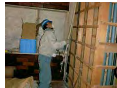
分別解体状況
