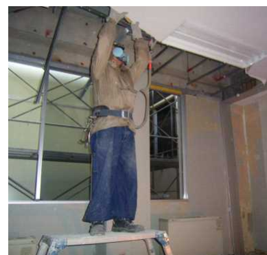
天井の撤去状況
