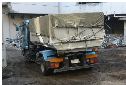
廃石膏ボードの運搬
