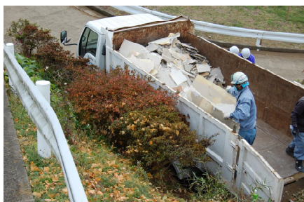
石膏ボードの積載
