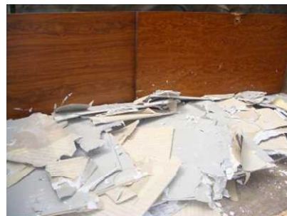
解体後の廃石膏ボードの保管
