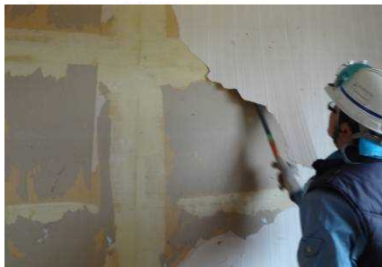
クロス類の撤去状況
