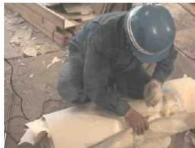
クロス類の結束状況
