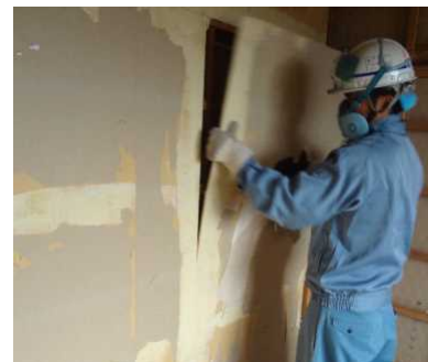
壁面の撤去状況
