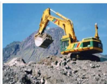
1994 土砂掘削に 無人化施工導入
