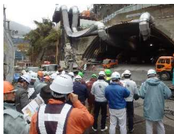
天ヶ瀬ダム再開発事業の見学ツアー(減勢池部)
