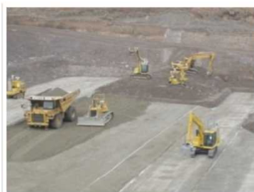
2003 スリット堰堤を 無人化施工
