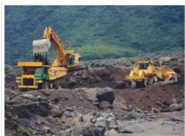
1995 世界初 砂防堰堤を無人化施工
