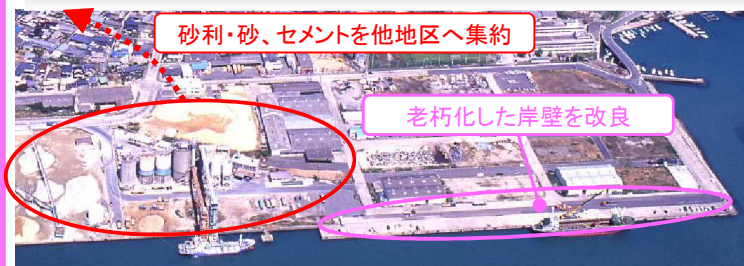
老朽化施設の改良及び貨物の集約
