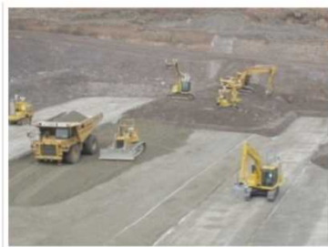
2003 スリット堰堤を 無人化施工
