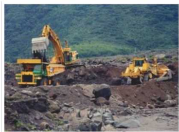
1995 世界初 砂防堰堤を無人化施工
