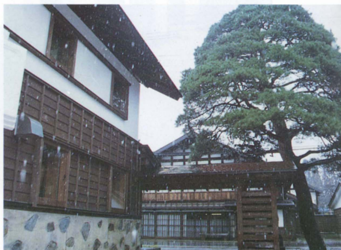
杉材と漆喰により修復された蔵
