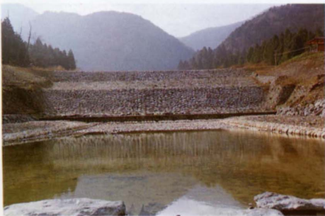
明治21年に完成した巨石積堰堤
