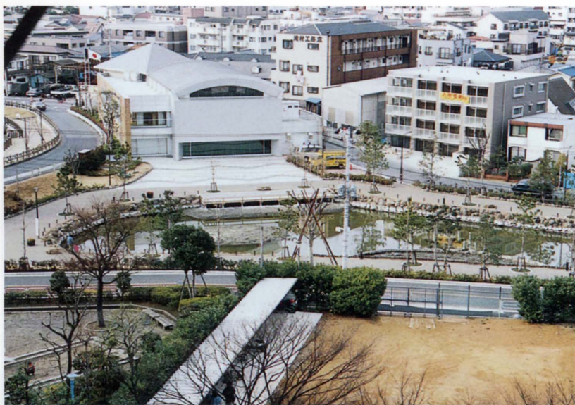
旧排水場を有効活用した新田コミュニティ会館
