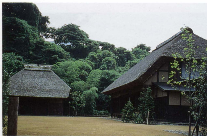
整備された古い民家
