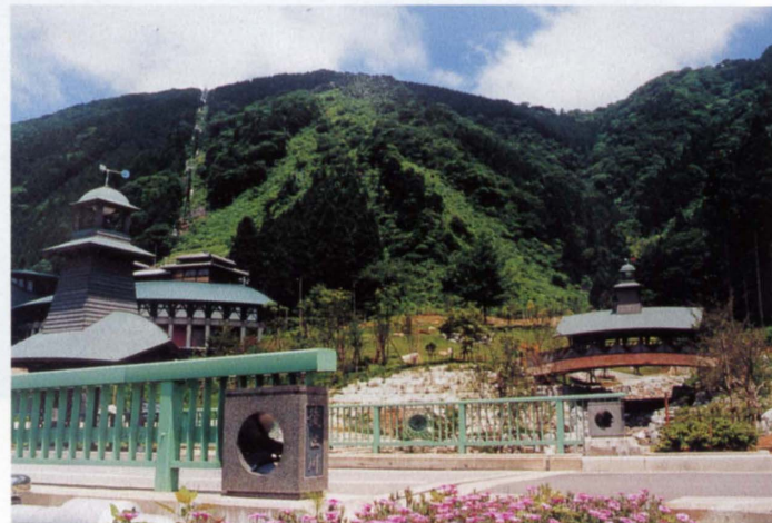
橋の上にも曲面のある上屋が設けられている
