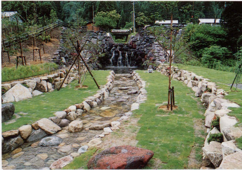
滝をイメージした床固工
