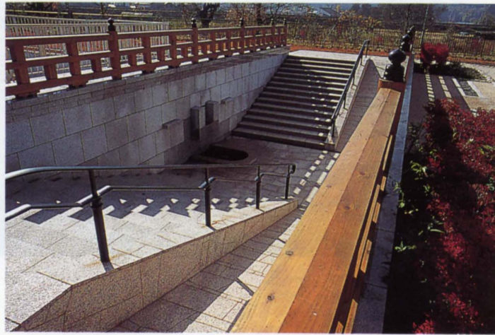
下水道処理水を観察することのできる放流渠修景施設
