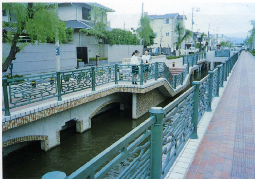
住民との話し合いにより設置された右岸歩道と親水テラス
