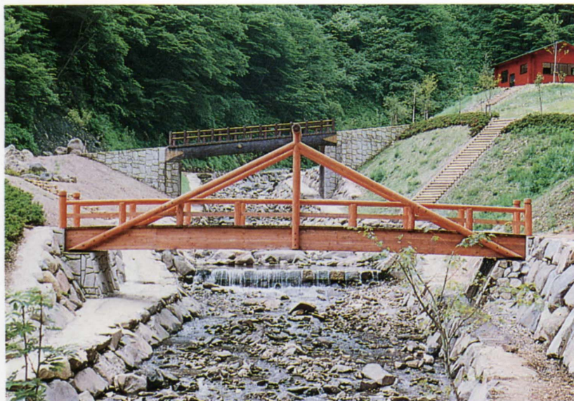
鉢伏山の形をモチーフにした公園内の橋
