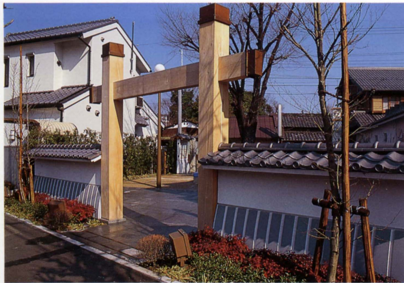
国道側に設けられた冠木門
