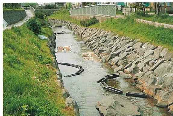
せせらぎには水生植物の生育に配慮して植栽樹が設置されている
