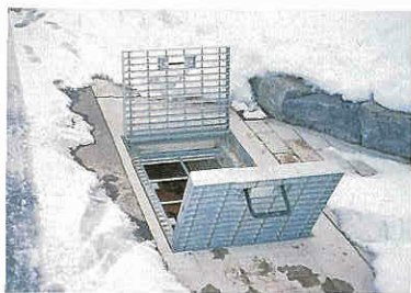
降雪地帯を考慮して流雪溝を設置
