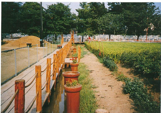
従来の畦道部分には木道を設置するとともに柵は簡素なものとしている
