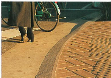
車道と歩道の段差にも配慮している
