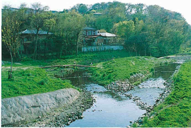
左が旧川, 右が新川で水辺から樹林帯まで連続する自然環境の保全が図られている
