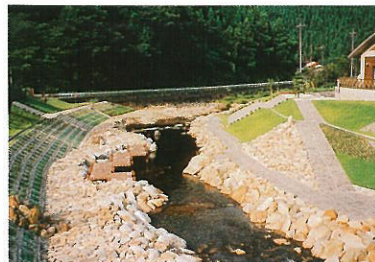
水性生物に配慮して自然石の石組みを採用
