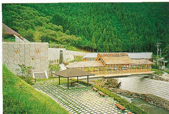
河辺川に架けられた屋根付き橋
