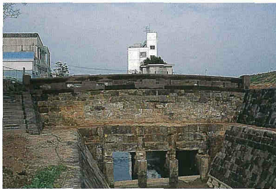
高欄は大正時代のコンクリート製から自然石のものになった
