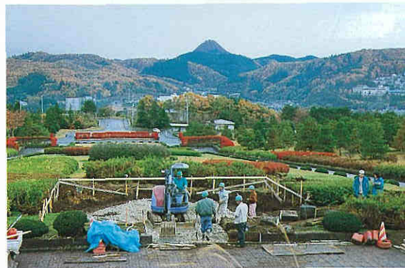
既存の背景を活かして彫刻の設置が行われている
