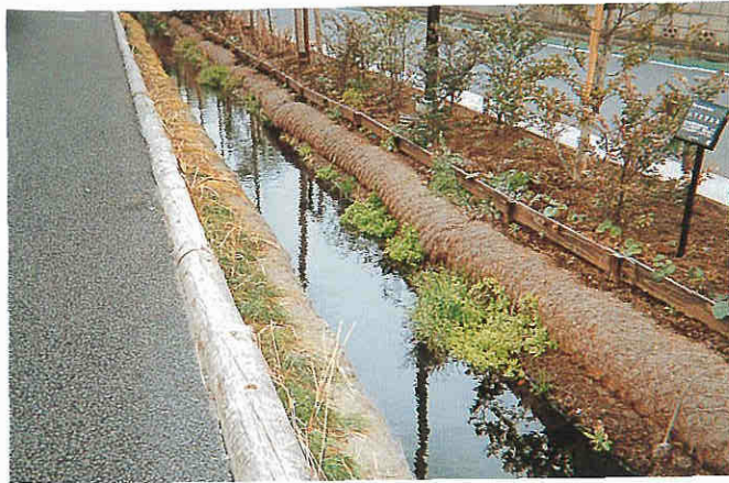
護岸には植生ロールを使用して水生生物の生息に配慮している
