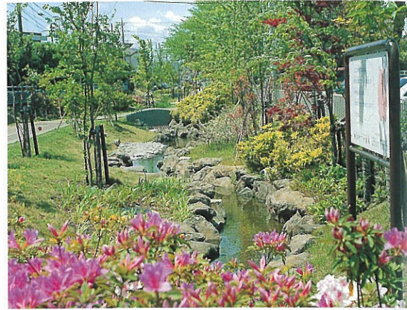
周辺が工業地域であることから植栽を施して潤いのある景観を創出
