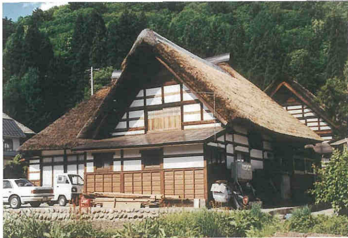
屋根や外壁等の修復整備が行われた曲家
