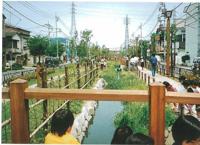
水路の法面部分は土で施工し植栽を施している
