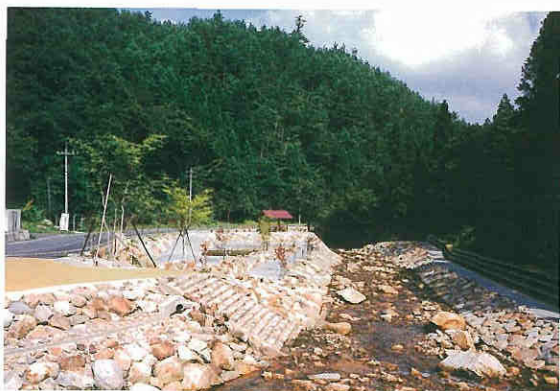
護岸整備には現地で発生した自然石を使用
