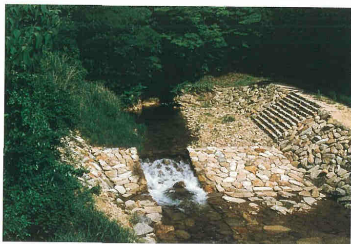
周辺の景観との調和を図った護岸整備
