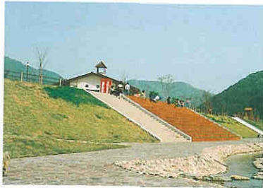
親水護岸を設けた道の駅に隣接する部分
