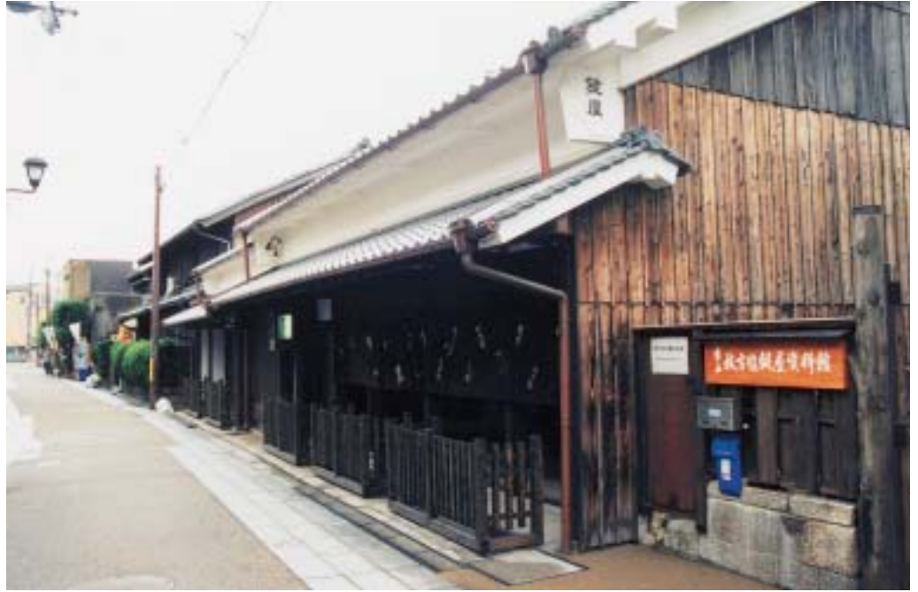
資料館とあわせ、石畳、自然色舗装、電柱の美装化を行っている
