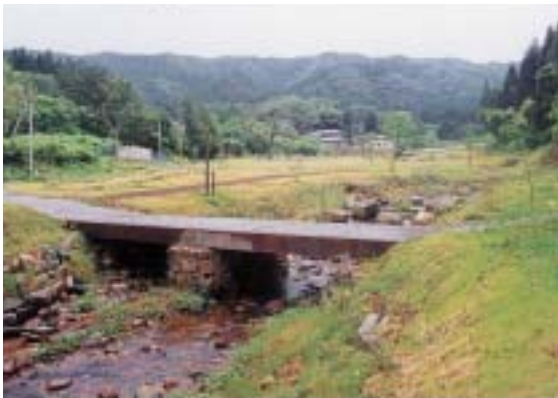
コンクリートが見えないPC橋（河底路）
