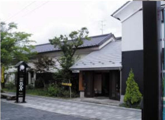
黒船オルゴール岩谷堂 蔵町モール整備に伴い、解体される「土蔵」の再利用
