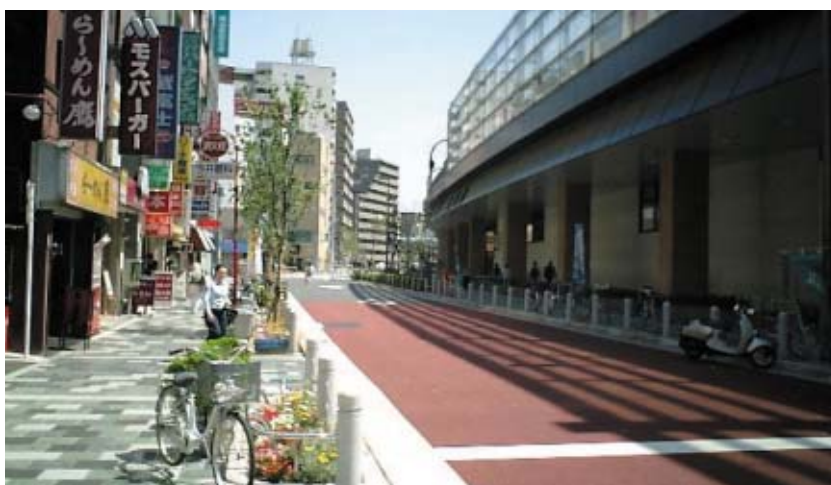
整備後の商店街
