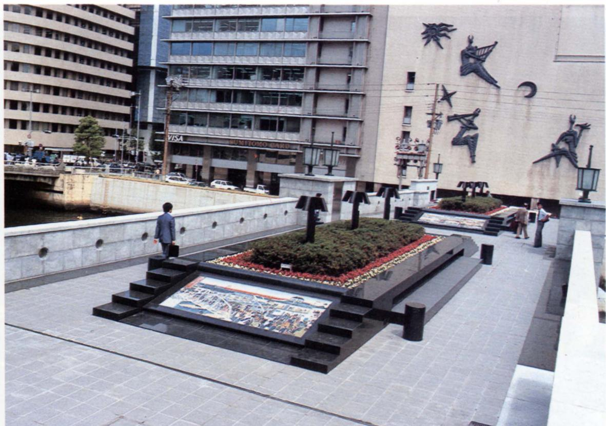
錦橋は、大阪を代表するオフィス街である中之島地区の西部に位置し、本体は市内堀川の水質を浄化する目的で設置された可動堰で、堰の上は、幅員一〇メートルの歩道橋として利用されてきた。このほど、築後五十年あまりを経過した構造本体の補修を機会に、全面的に景観などを考慮した形で歩道橋部分の改修が行われた。外壁を化粧直しし、橋面の中央部に御影石を用いた大きな植栽枠を設置、その壁面には江戸末期から明治初期にかけての大坂の橋を描いた錦絵を装飾している。これを緑のベンチとして利用するとともに、また、橋面には、落ち着いたグレータイルを敷きつめ、橋詰には、古地図、橋の番付表、歴代の橋の写真を展示した。
