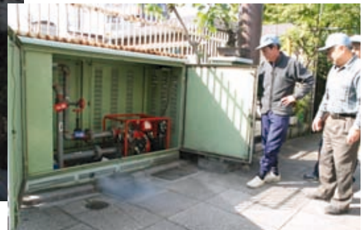
路地に備え付けられた消火栓
