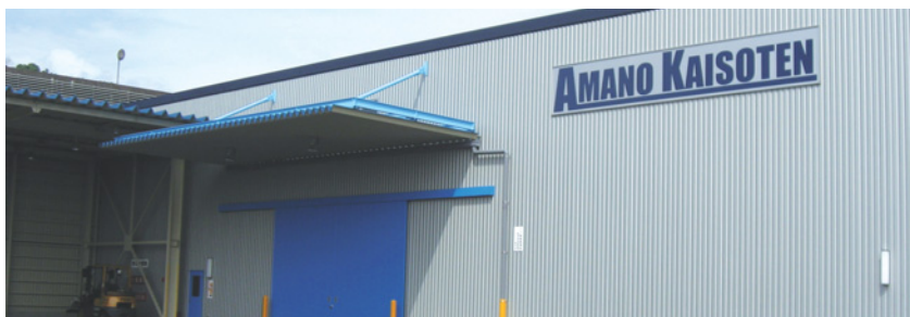
▲倉庫の新築事例
