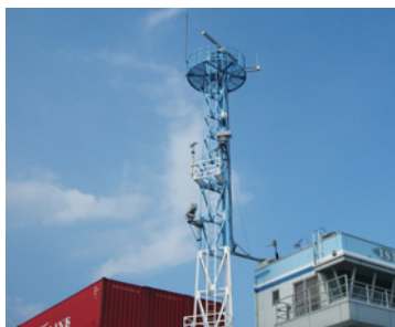
▲レーダー用鉄塔の塗り替え事例
