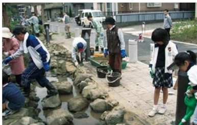
雑草対策(目地詰め)作業
