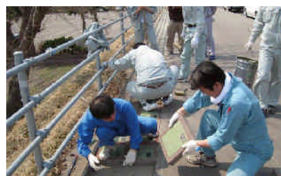
足型敷設作業風景「一枚ずつ手作業で敷設」
