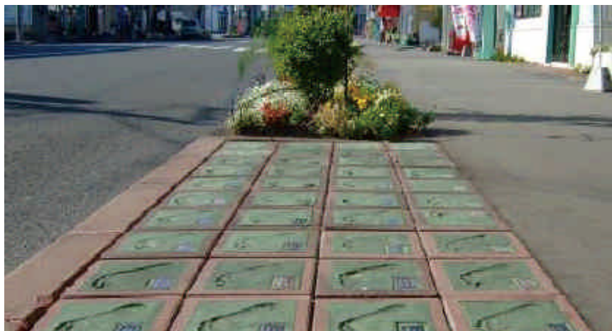
国道241号歩道への足型敷設状況
