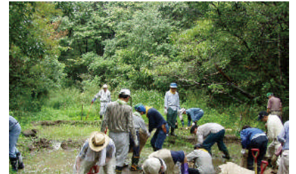
貴重な天白溪と湿地も長年放置され土砂で埋まっており、土のう積みで回復作業をする
