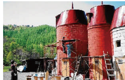
駅通所に隣接するサイロ修復風景
