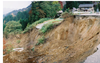
中越大震災での被害（県道の崩落）
