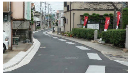
地域の特性を活かした路面の改修工事
