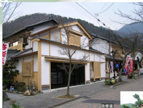
参道沿いの店舗の改修状況
