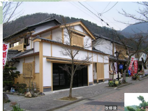
参道沿いの店舗の改修状況
